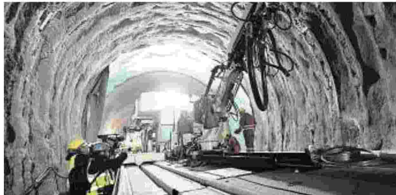
Il cantiere della Tav
