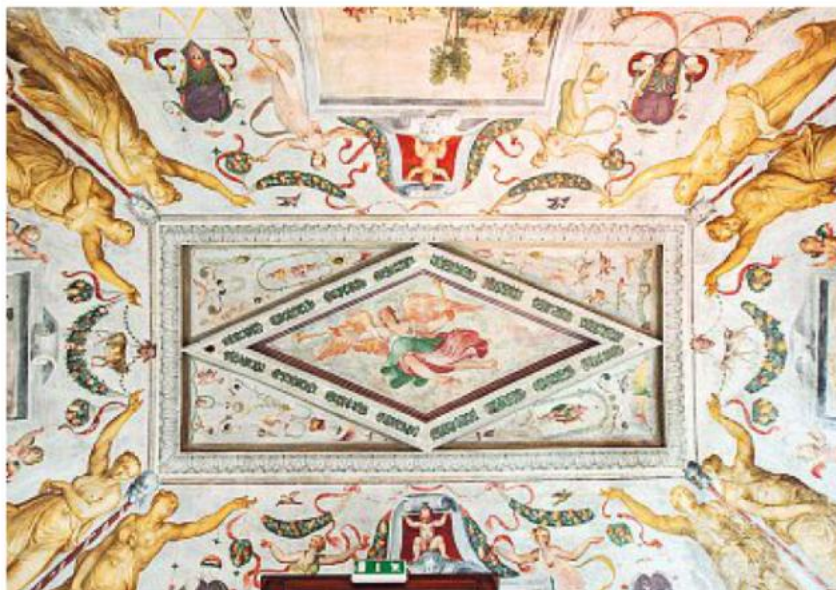
Da recuperare La volta di uno dei piani di palazzo Bocca Trezza, parte del progetto finanziato dal Bando periferie
