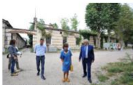
Uno degli edifici fatiscenti visitati durante il sopralluogo
