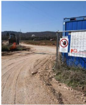
L'area di Terramatta scelta da Serit per la costruzione dell'impianto
