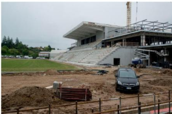
Il cantiere alla Spianà procede veloce: la fine lavori è prevista per Ferragosto. FOTO MARCHIORI
