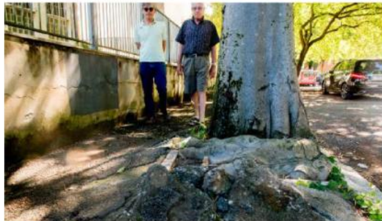
Un marciapiede di via Da Verrazzano devastato dalle buche e dalle radici. FOTOMARCHIORE
